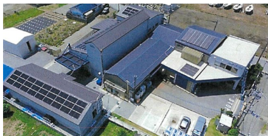
工場屋根に設置した太陽光発電設備
