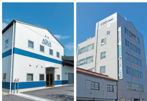
工場(左) 本社ビル(右)
