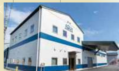
須越工場新社屋・自動倉庫
